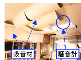
図1 吸音材設置状況
